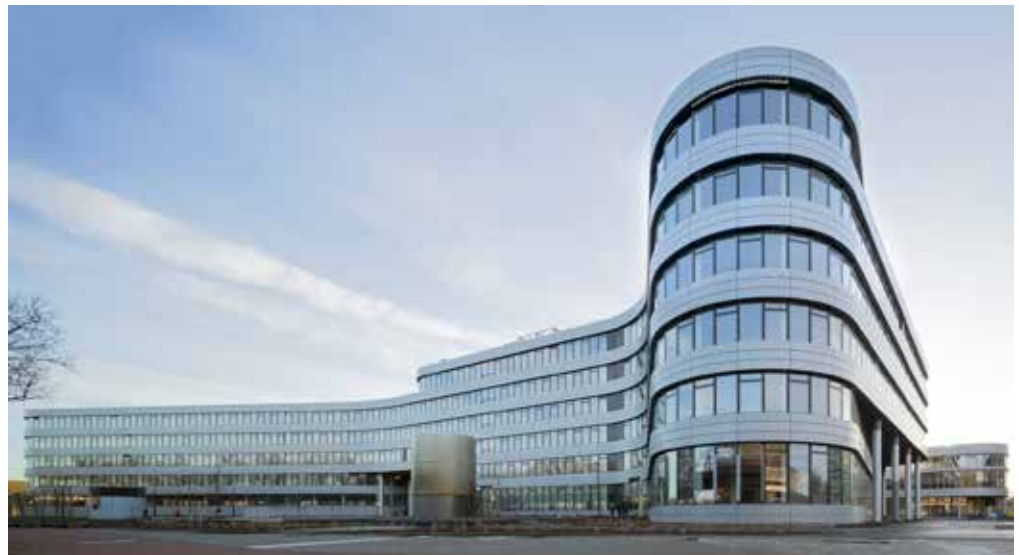
Hauptverwaltung der RheinEnergie in Köln-Ehrenfeld.
