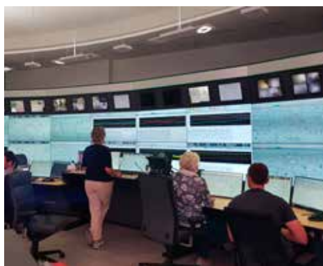
Die neue Leitwarte bei der MVL.
