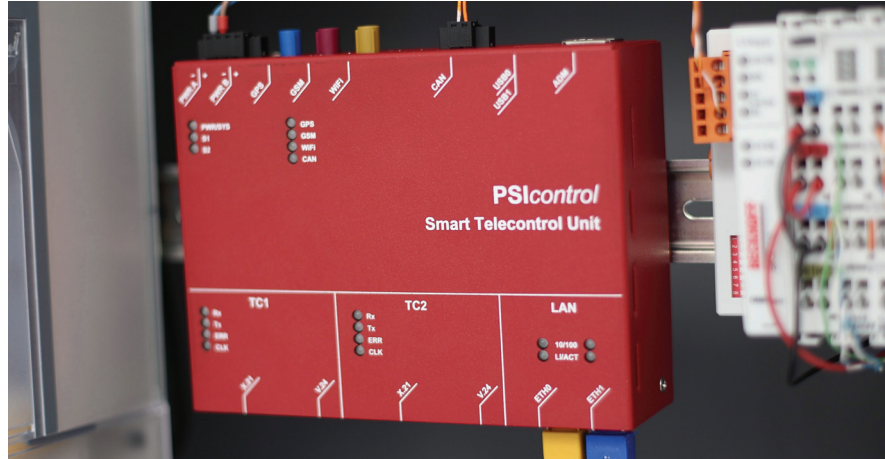
Intelligente Netzkomponente für die lokale und autonome Steuerung von Micro Grids
